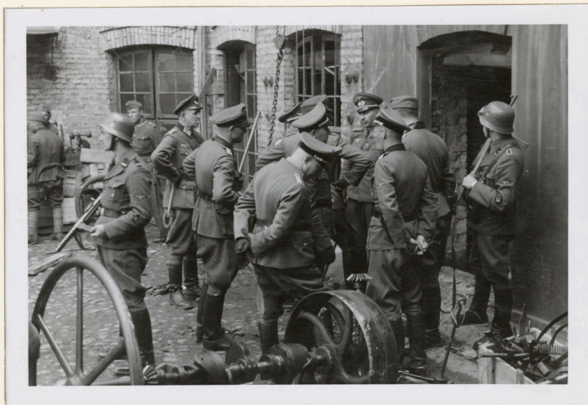
Die Räumung eines Bunkers wird begonnen.
