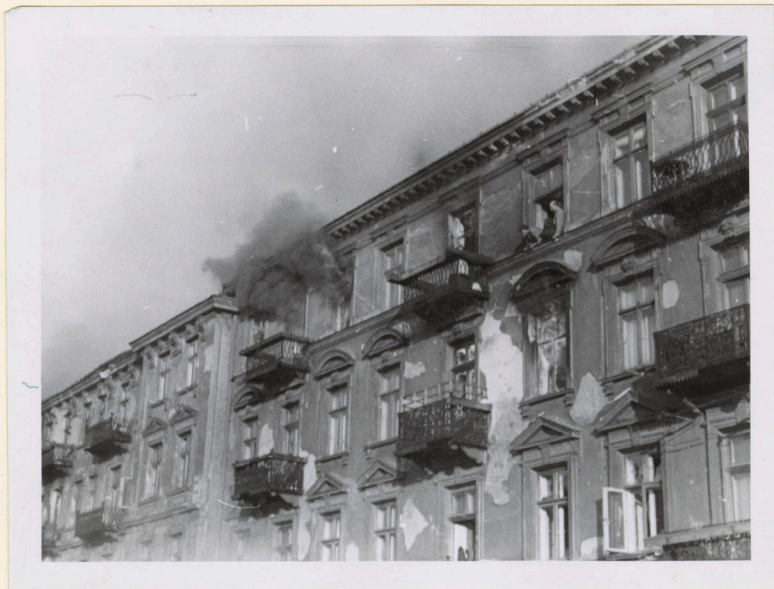
Die Bomben zerstören die Fassade des Hauses.
